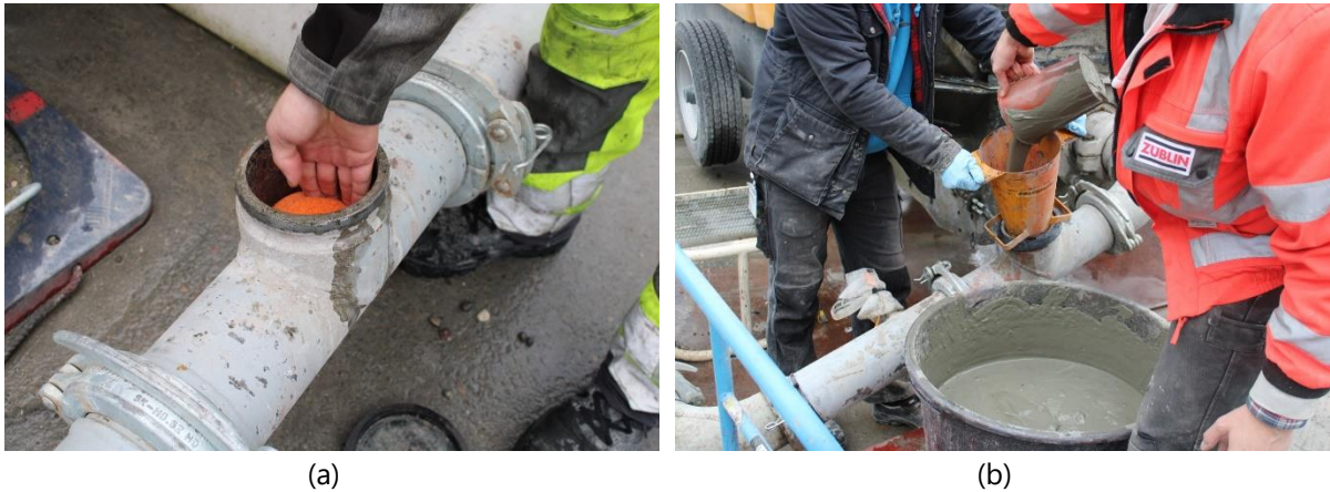
Abbildung 3-17: Vorbereitung der Vorlaufmischung (a) einsetzen der Schwammkugel (b) befüllen mit Zementleim [Foto: Mikhalev].
