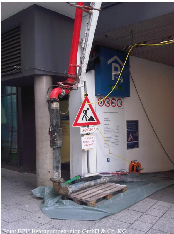
Abbildung 1-1: Förderschlauchführung beim Bauen im Bestand: Betonage in einer Tiefgarage.
