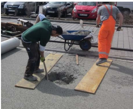
Abb. 19: Aushub der Aussparung für Schachtring
