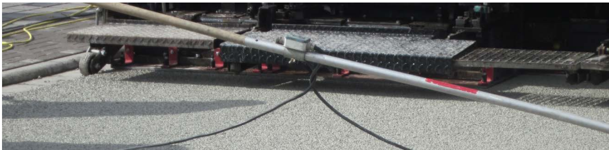
Abb. 18: Rollensystem an der Einbaubohle des Fertigers
