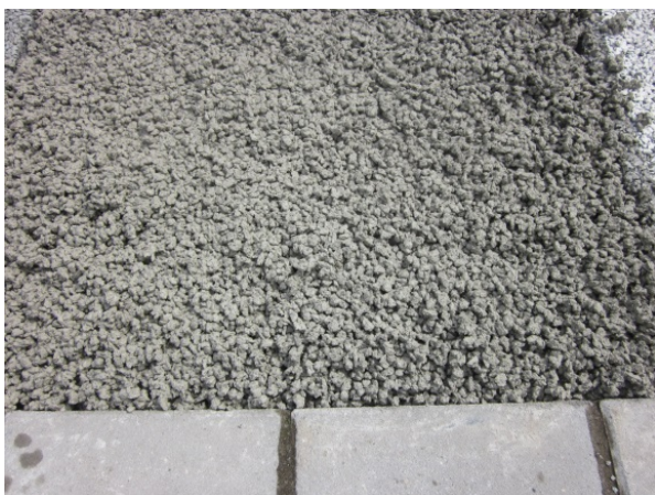
Abb. 48: Beton vor dem Verdichten
