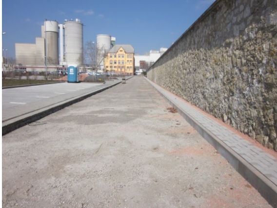
Abb. 16: Blick auf die ungebundene Tragschicht
