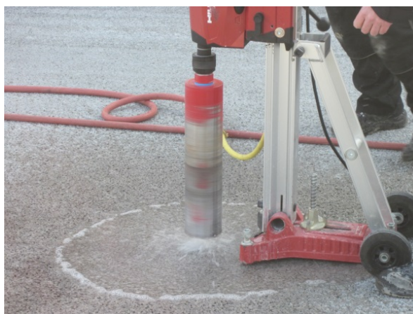
Abb. 34: Bohrkernentnahme
