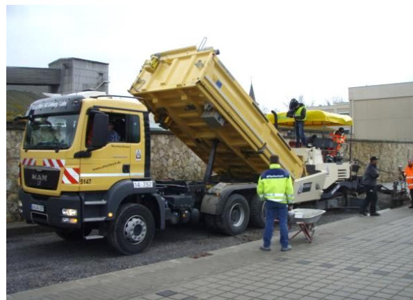
Abb. 23: Kipper - Transport (abgedeckt mit Plane)
