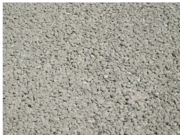
Abb. 49: Beton nach dem Verdichten
