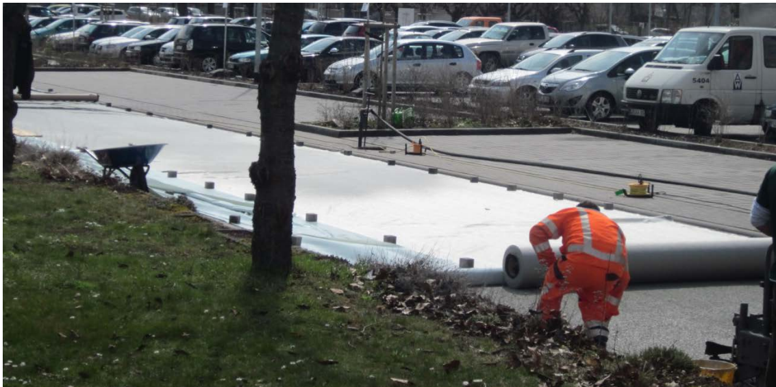
Abb. 21: Abdeckung der Oberfläche mit Folie unmittelbar nach dem Einbau (Nachbehandlung)
