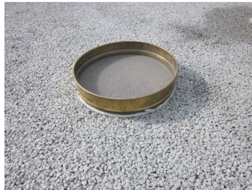
Abb. 5: Wasserdurchlässigkeit der eingebauten Fläche
