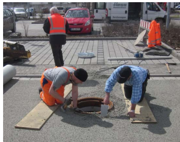
Abb. 20: Einbau eines Schachtringes
