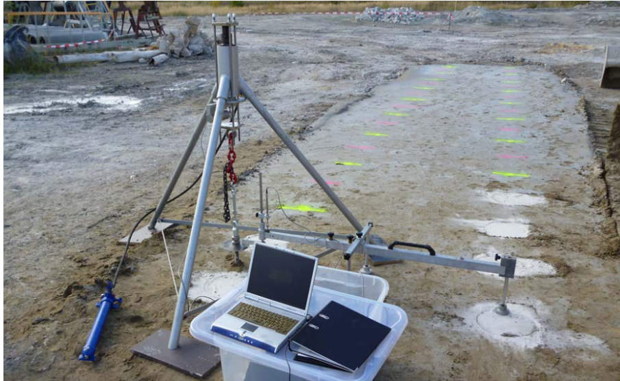
Abbildung 4-7: Exemplarische Durchführung des Pfahlzugversuches am eingebauten ZFSV
