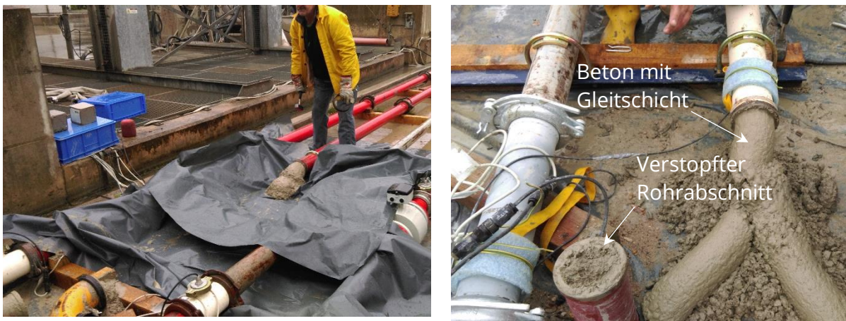
Bild 33. a) Unterbrechung des Pumpvorgangs nach einem Rohrstopfer und b) Fortsetzen des Pumpvorgangs nach seiner Beseitigung [30].
