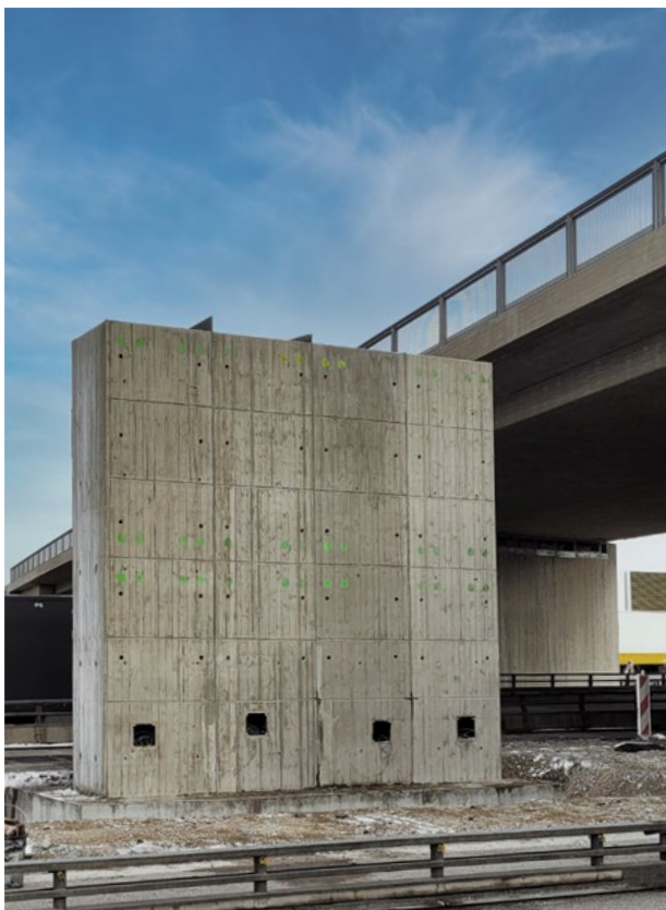
Demonstratorbauteil an der A 99 zur Bewertung der Dauerhaftigkeit von Stahlbeton, gemeinsame Forschung der Hochschule München, der Autobahn GmbH, der Ruhr-Universität Bochum und der Technischen Universität München
