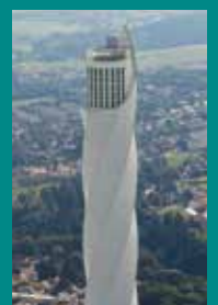
Aufzug-Testturm in Rottweil
