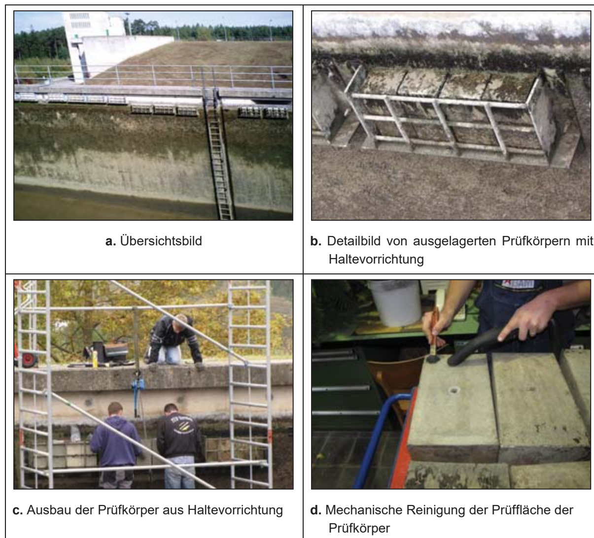
Bild 2: Impressionen von der Lagerung, dem Ausbau und der Reinigung der Prüfkörper des Spärbeckens der Schleuse Hilpoltstein
