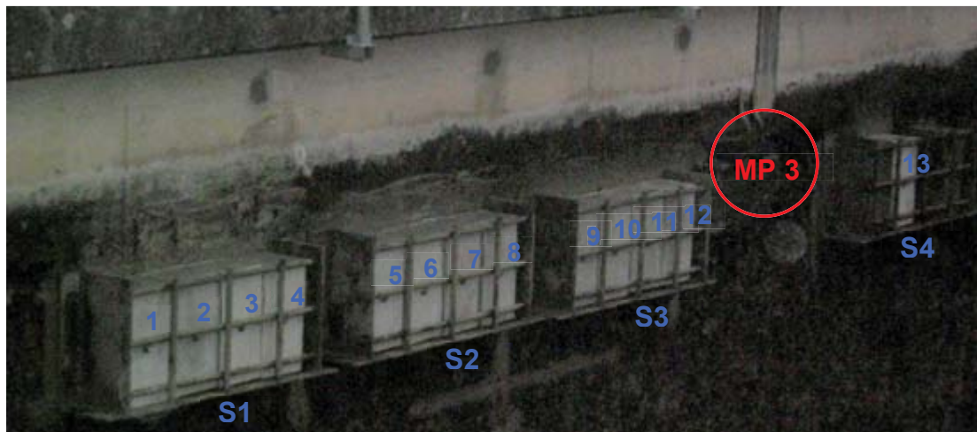
Bild 2: Ausgelagerte Probekörper an der Sparbeckenwand der Schleuse Hilpoltstein
