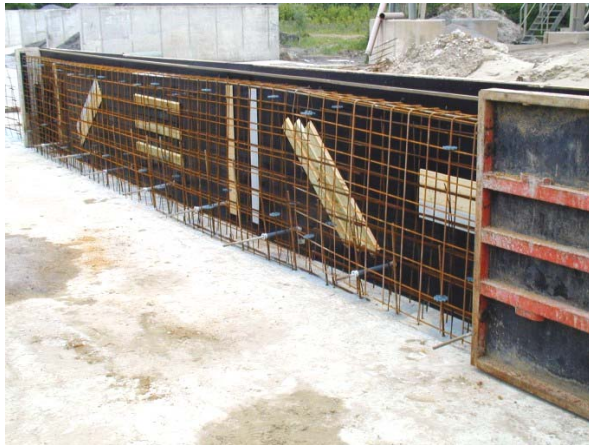
Bild C8: Probewand 1 – Abschnitt 1 - Schalung
