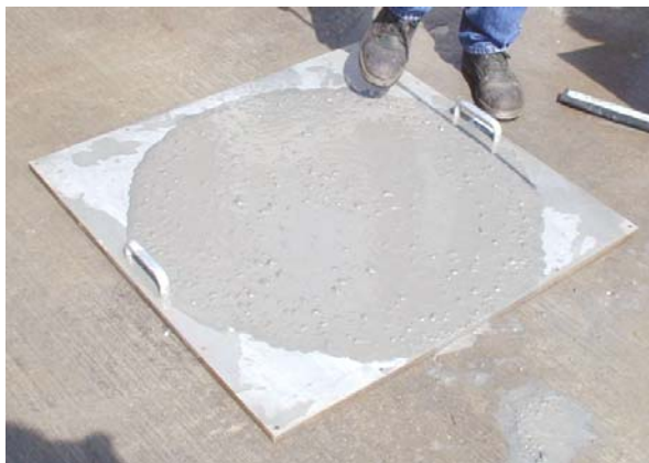
Bild C12: Betonage Abschnitt 1 (t = 40 min, sm = 89 cm, T = 5 s)
