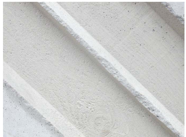
Bild C33: Betonage Wand 2 - Einfluss der Schaloberfläche
