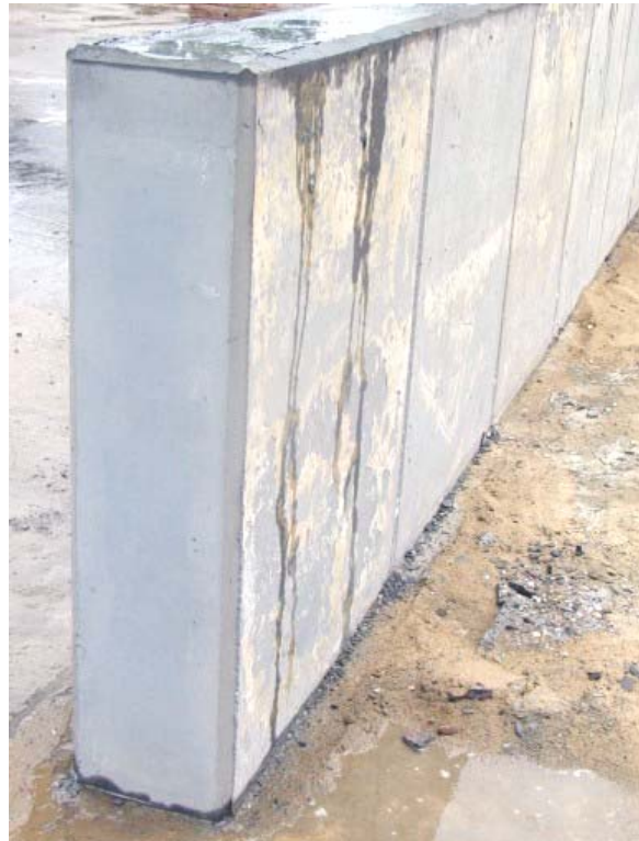
Bild C35: Betonage Wand 2 - Einfluss der Schaloberfläche
