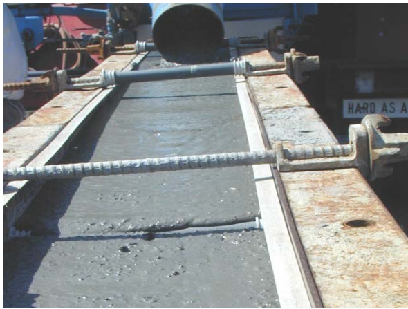
Bild C30: Betonage Wand 2 - Herstellung
