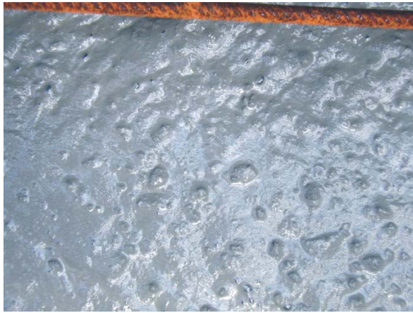
Bild C28: Betonage Wand 2 - Herstellung
