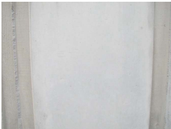
Bild C32: Betonage Wand 2 - Einfluss der Schaloberfläche
