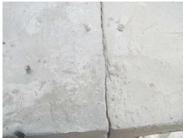
Bild C37: Ansatz Wand 2 (Abschnitt 2) an Wand 1 (Abschnitt 1)
