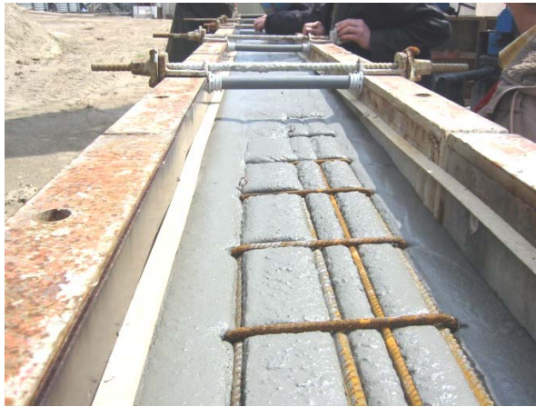
Bild C16: Betonage Abschnitt 1 - Herstellung
