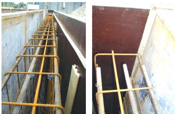
Bild C10: Probewand 1 – Abschnitt 1 - Schalung
