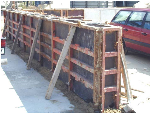
Bild C24: Probewand 2 – Abschnitt 2 - Schalung
