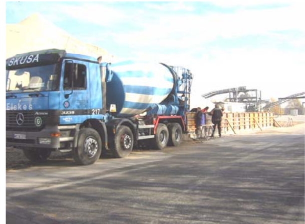
Bild C43: Betonage Probewand 3 - Einbau t = 65 \text{ min}
