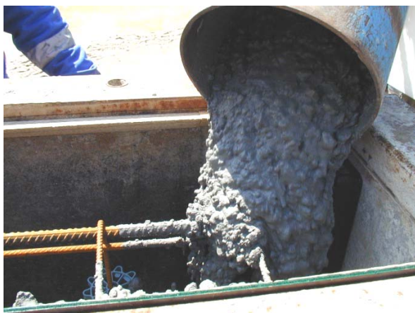
Bild C14: Betonage Abschnitt 1 Einbaubeginn 105 Minuten nach Herstellung
