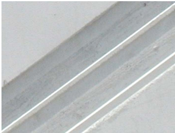
Bild C18: Betonage Abschnitt 1 – Einfluss der Schaloberfläche
