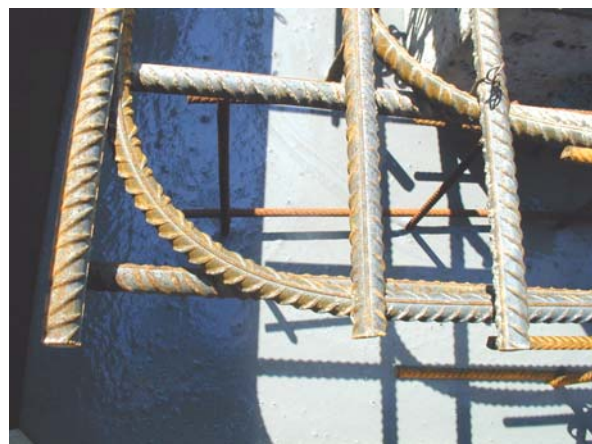
Bild C15: Betonage Abschnitt 1 - Herstel- lung
