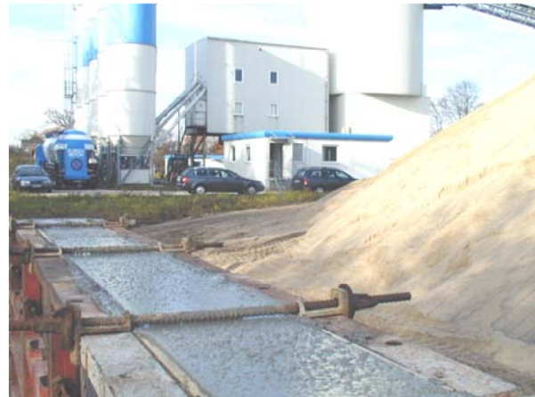
Bild C47: Betonage Probewand 3 - Herstellung
