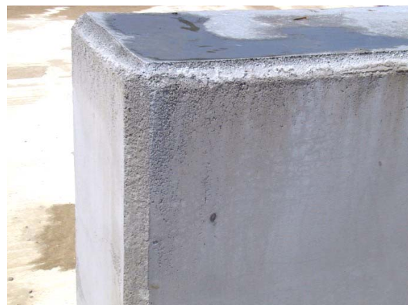
Bild C21: Betonage Abschnitt 1 – Sedimentationseffekt
