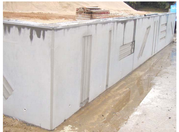
Bild C31: Betonage Wand 2 - Einfluss der Schaloberfläche
