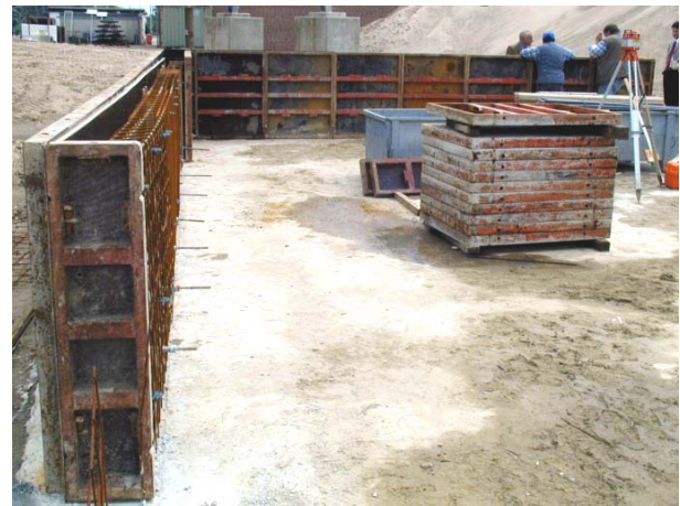
Bild C7: Probewand 1 – Abschnitt 1 - Schalung
