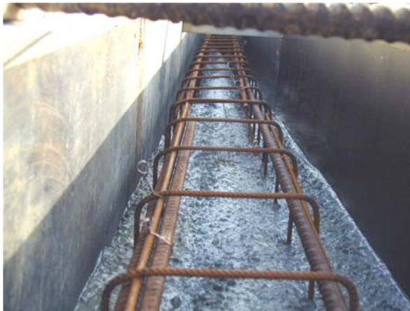
Bild C46: Betonage Probewand 3 - Herstellung
