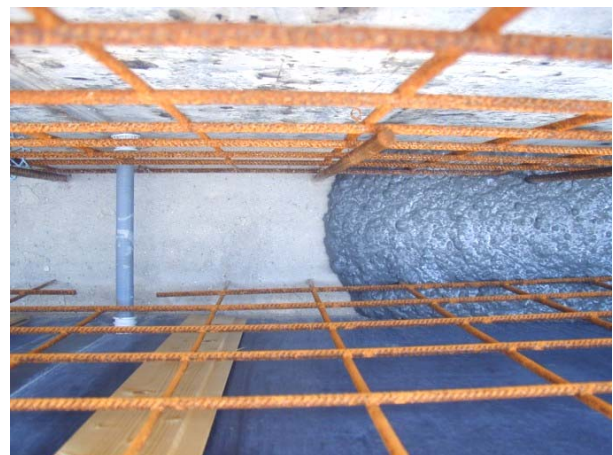
Bild C27: Betonage Wand 2 - Herstellung
