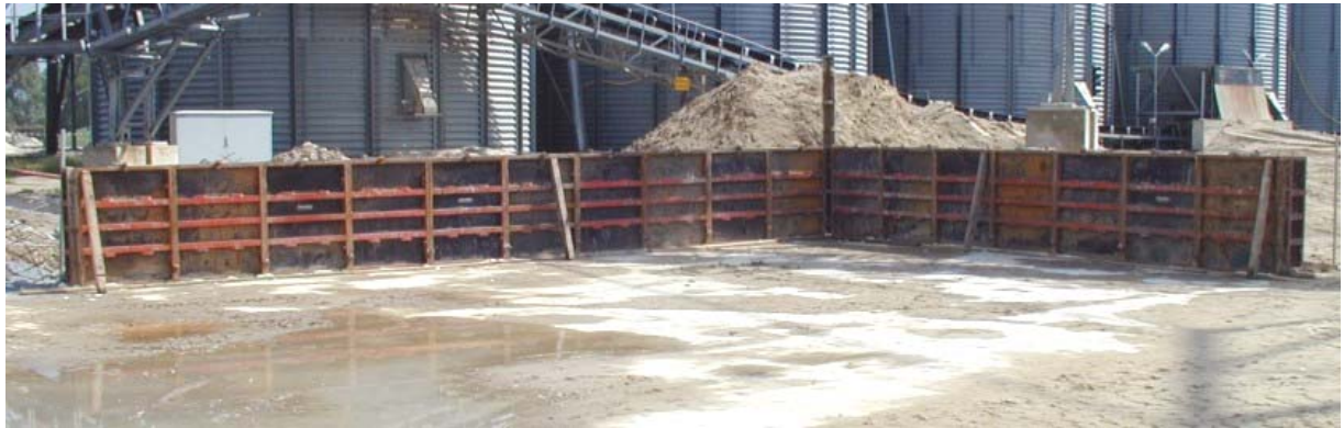
Bild C11: Probewand 1 – Abschnitt 1 - Gesamtübersicht
