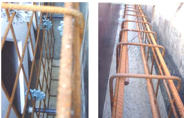
Bild C44: Betonage Probewand 3 - Her- stellung
