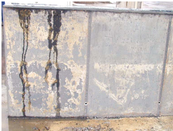
Bild C36: Betonage Wand 2 – Einfluss der Schaloberfläche
