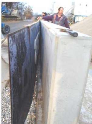
Bild C48: Probewand 3 - Ausschalen
