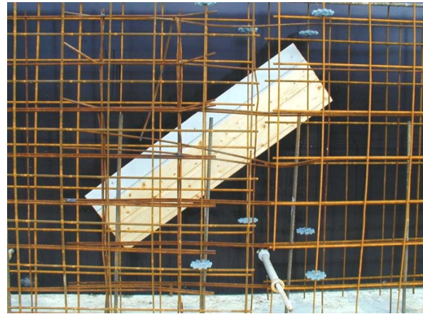
Bild C9: Probewand 1 – Abschnitt 1 - Schalung
