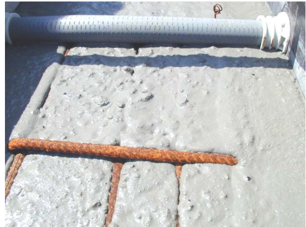
Bild C29: Betonage Wand 2 - Herstellung
