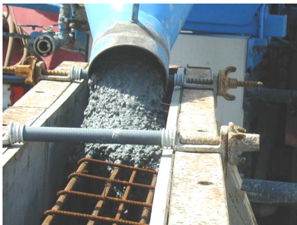
Bild C26: Betonage Wand 2 - Herstellung
