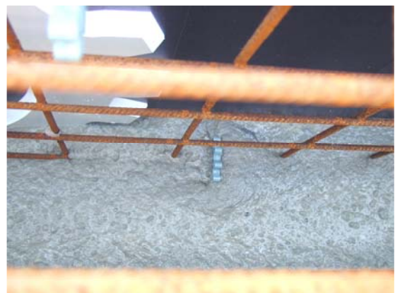
Bild C45: Betonage Probewand 3 - Her- stellung
